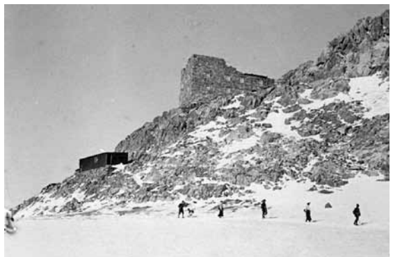
Baustelle des Brandenburger Hauses – fotografiert vom Venter Kuraten Georg Thöni
